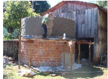
Construção de silo – Coronel Vivida.
