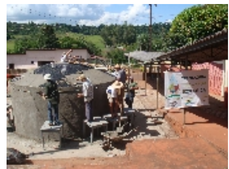
Cisterna – Escola em Capanema
